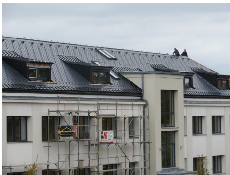
Budova školy s novou střechou
